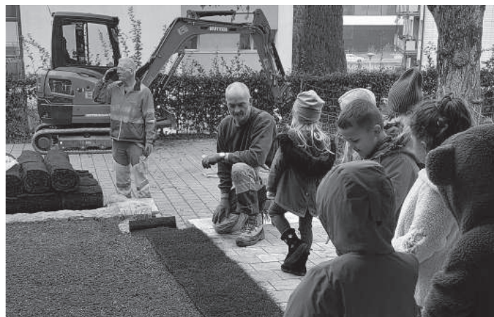
Die Kinder vom Kindergarten Höfli verfolgen gespannt, wie der neue Rasen verlegt wird.
